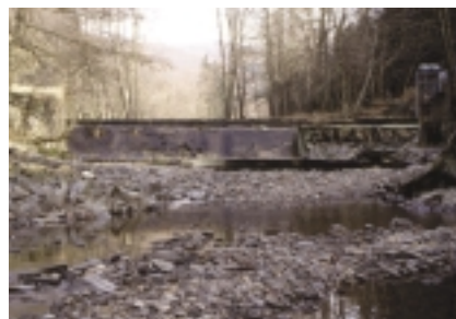
4. Künstlich trockengefallender Abschnitt der Sieber oberhalb Herzberg. Dem Fluss wird an einer Wehranlage das gesamte Wasser zur Erzeugung von erneuerbarer Energie (Strom) entzogen. Hier geht der Schutz der Umwelt (Reduktion von CO 2 ) auf Kosten der Natur.
